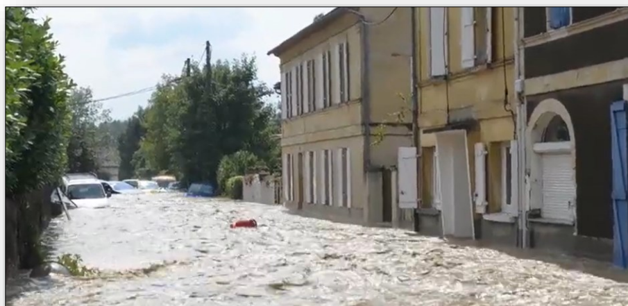
Au bourg de Paillet, l'Artolie est sortie de son lit et s'est transformée en torrent (juillet 2022)
