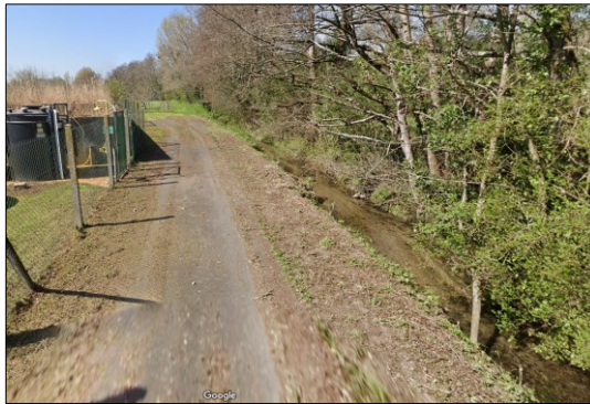
Ruisseau du Moulinan à Quinsac, près de la station d'épuration
